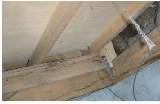
筋かい端部接合金物の確認
