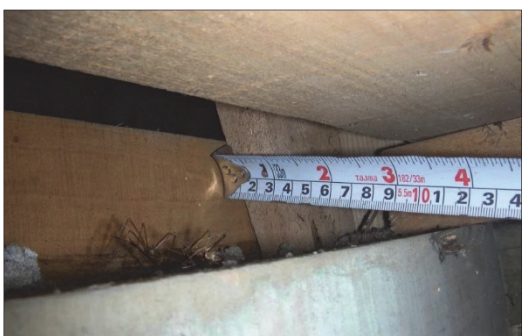
筋かい断面の確認
