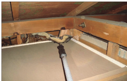
筋かいの確認（断熱材の裏）
