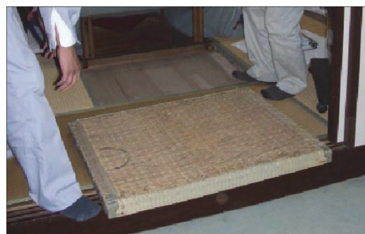
和室からの調査
