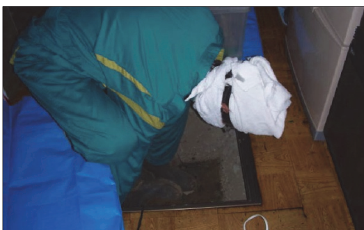
床下収納庫からの調査
