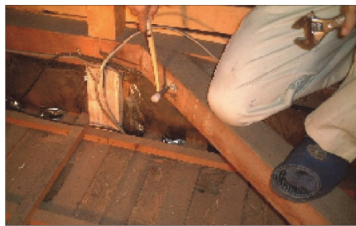
火打ちの確認（ボルトの有無）
