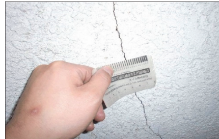
外壁のひび割れ幅の確認
