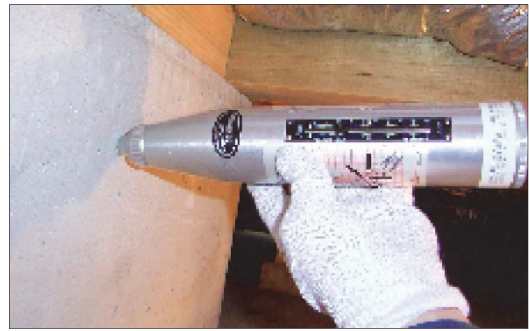
基礎の圧縮強度の測定
