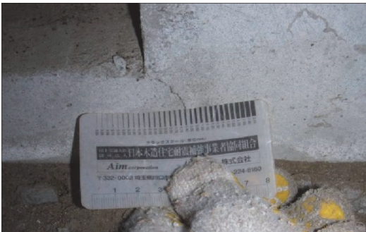
基礎ひび割れの確認
