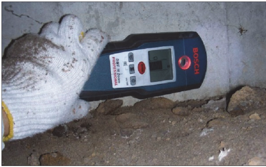
基礎の有筋・無筋の確認
